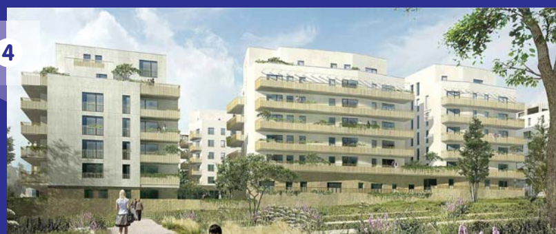
4 DIAGONALE « Le Quai Florentin » - Architectes : Arto et Gauthier Conquet 159 logements dont 40 pour Grand Lyon Habitat (logement social)
